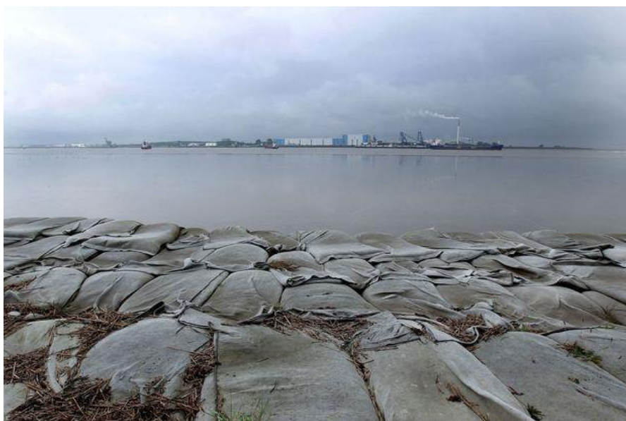
Aus den Sandsäcken, die für den Bau des OTB gestapelt wurden, wächst bereits Grün heraus. (Frank Thomas Koch)
